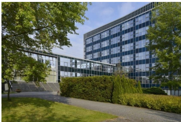
NÁRODNÍ KULTURNÍ PAMÁTKA Budova ústavu, realizovaná v letech 1960 – 1964 podle projektu architekta Karla Pragera, patří k nejvýznamnějším českým architektonickým dílům poválečného období.
