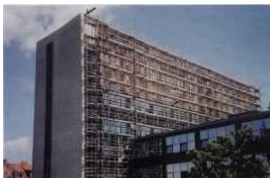
Jižní fasáda budovy A v průběhu rekonstrukce pláště. Foto: Miloslav Pavlík
