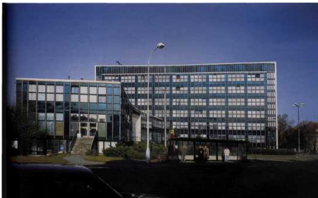
Pohled z Náměstí Heyrovského na jižní fasádu. Foto: Archiv ateliéru Gama
