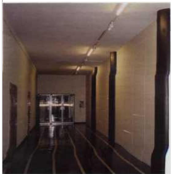
Chodba v objektu B. Rekonstrukce probíhala za plného provozu objektu. Aby mohl být vyměněn vnější plášť, bylo třeba oddělit vnitřní prostory budovy sádrokartonovými příčkami. Foto: Miloslav Pavlík
