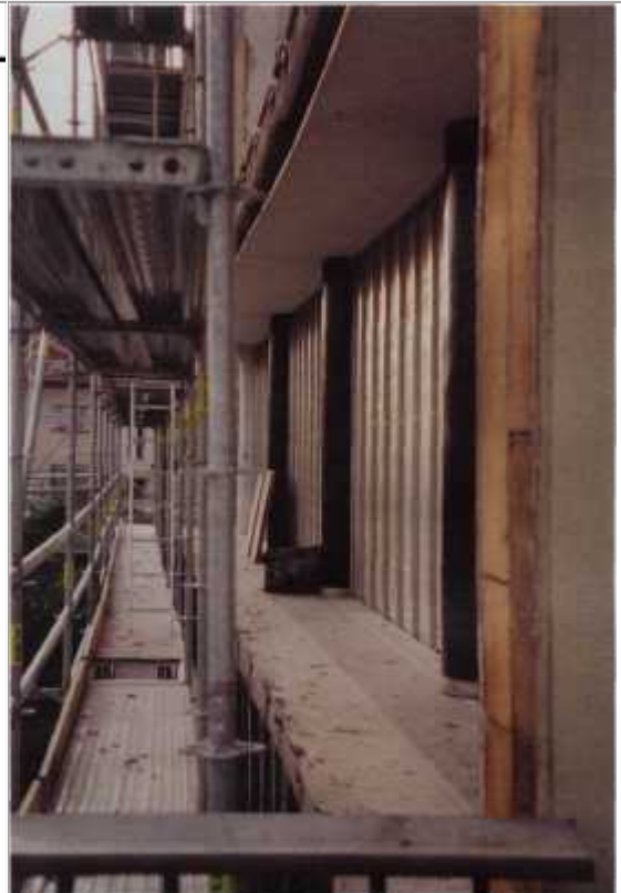
Severní fasáda při rekonstrukci. Vložení dělicí sádrokartonové příčky byl vytvořen optimální prostor pro montáž nového pláště. Foto: Miloslav Pavlík
