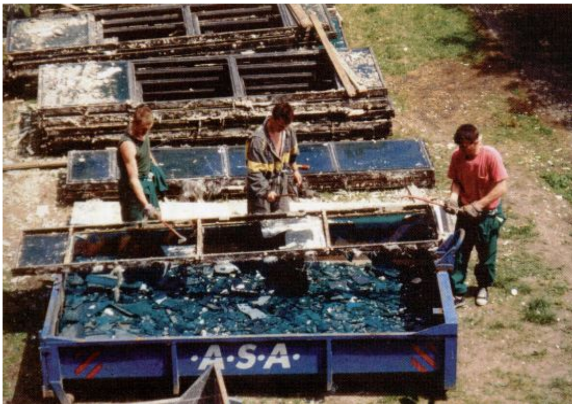
Třídění sneseného obvodového pláště pro recyklaci
